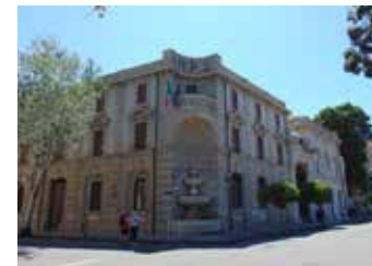
Fig. 10. Veduta esterna del Palazzo INPS e del portale d'ingresso alla galleria, via Consolata del Mare, via Argentieri. Fotografia di Raimondo Mercadante, Giugno 2025.
