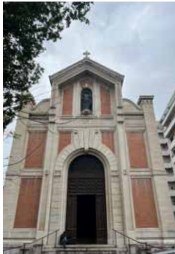
3. Chiesa di Santa Rosalia, vista prospetto principale e laterale. Fotografia V. Bonura.
