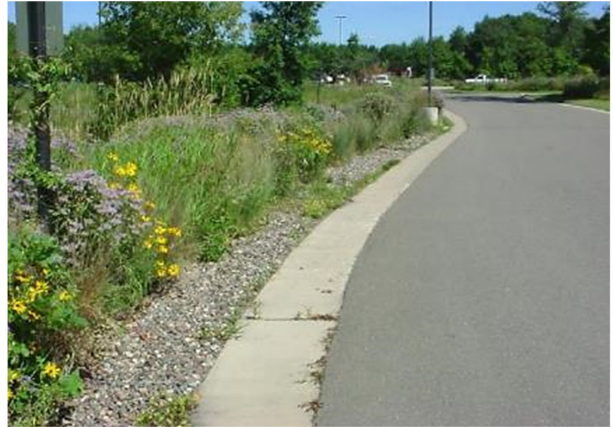
Dreni e trincee infiltranti
