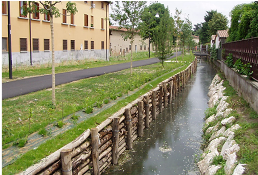
Palizzata e scogliera spondale
